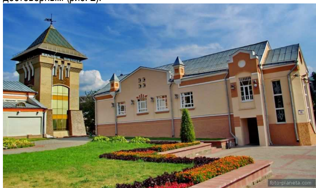
Рис. 2. Воссозданная в 2007 г. башня в Витебске
