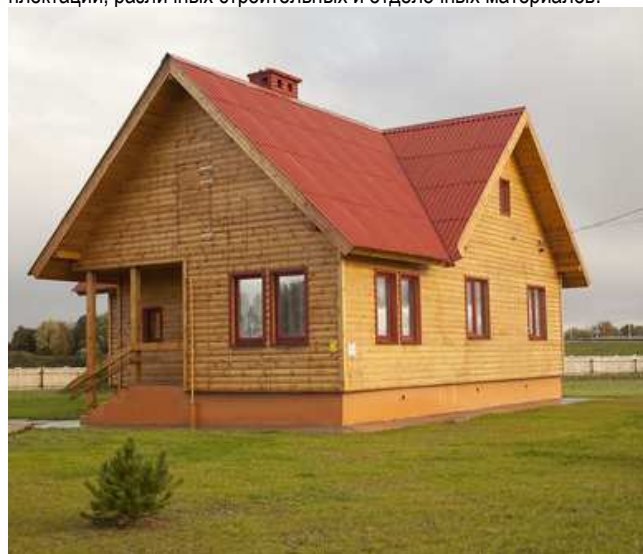
Рис. 3. Каркасно-панельный дом, построенный по проекту «Александрия»
